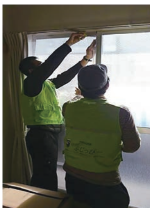
上段：ビニールシートに覆われた住宅 左：断熱材の取り付け作業
