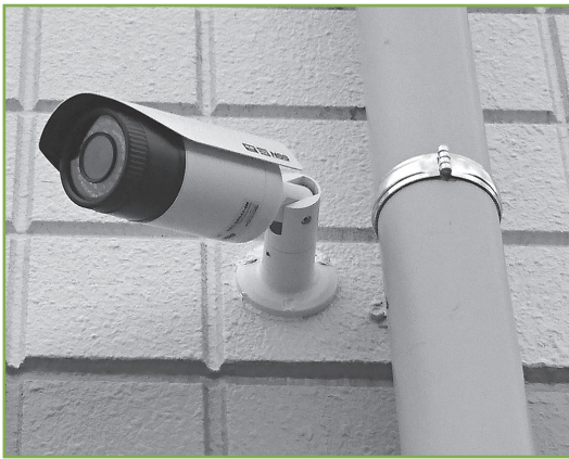
施設の外周をくまなくチェック
