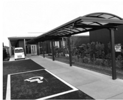
リニューアルしたエントランス
